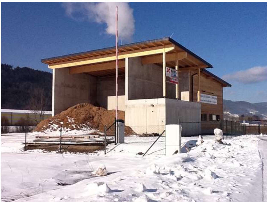
Abb. 19: Biomasseheizwerk Oberwang (HEIZWERK-OBERWANG.AT 2018)
